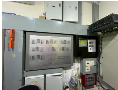
รูปที่ 2-36 แผงควบคุม (Fire Alarm Control Panel: FCP)
