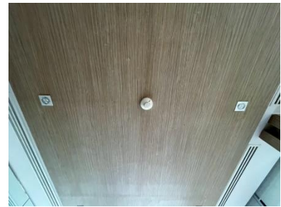
รูปที่ 2-37 เครื่องตรวจจับควัน (Smoke Detector)
