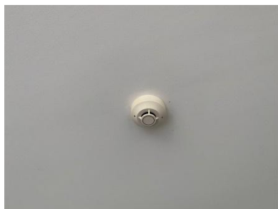
รูปที่ 2-38 เครื่องตรวจจับความร้อน (Heat Detector)
